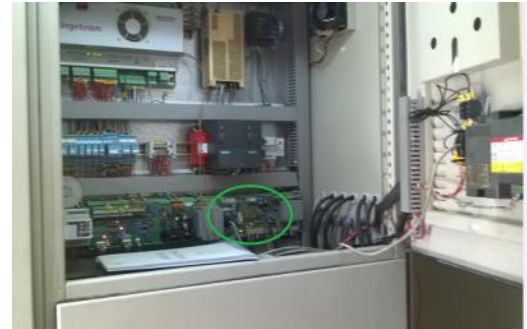
Interior del armario ground. Señalado en un recuadro, zona donde se ubican las conexiones de señal.
