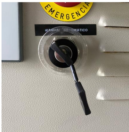
Selector en posición manual. Manual position selector.
