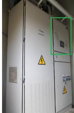
Armario ground. Señalado sobre la foto, el habitáculo donde se aloja las comunicaciones remotas y el display.
